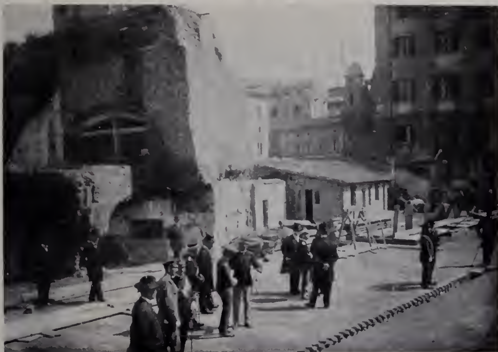
294. — Vittorio Emanuele III con la missione Giapponese visita i lavori
